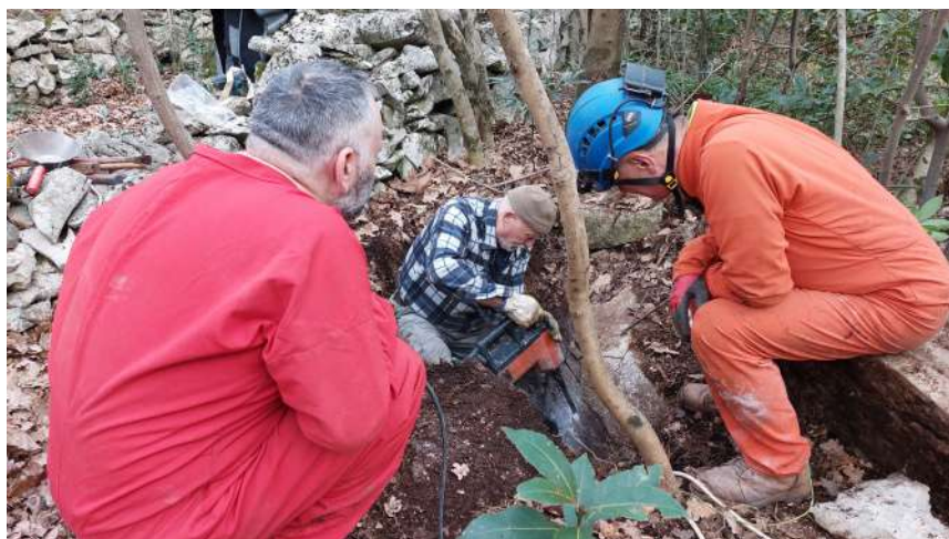
Lavori di allargamento dell'ingresso (foto M. Bottegal)
