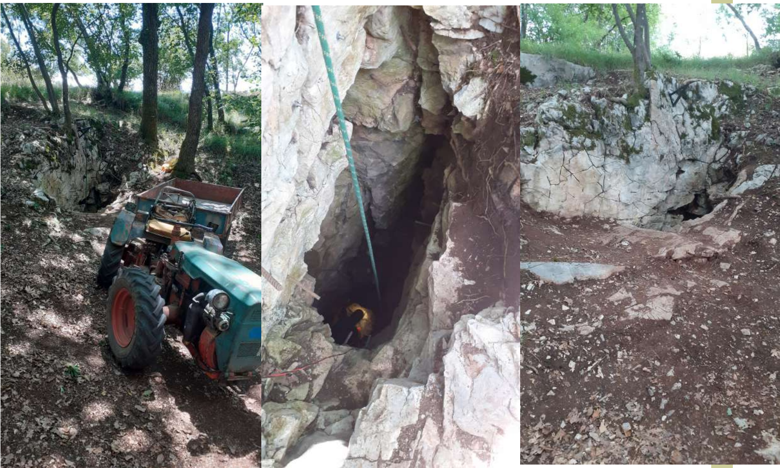
Alcune immagini della zona d'ingresso della grotta. A sinistra: si porta via il materiale scavato grazie a Ludvik e al suo trattore con rimorchio; al centro: l'imbocco del pozzo iniziale; a destra: la parete all'ingresso dopo i lavori con l'escavatore (foto G. Benedetti)
