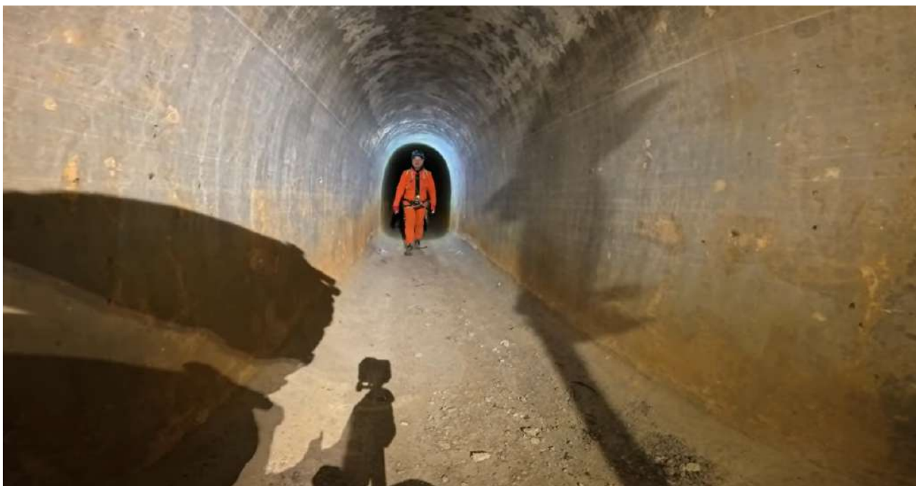
Il tunnel artificiale che ha intercettato la grotta (foto R. Trobec)
