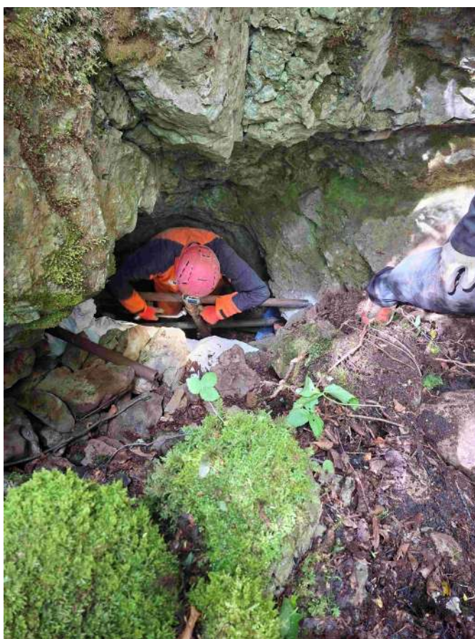
Si posizionano i tubi Innocenti per contenere la frana mobile (foto G. Benedetti)
